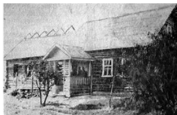
Д.Перехожка. Строительство клуба и конторы совхозного отделения. 1958 г.
